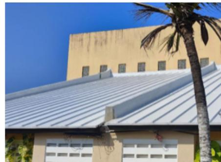
Um ponto crítico no andamento da reforma foi a constatação da presença de pontos de ferrugem em algumas telhas já assentadas e em outras que ainda estavam no canteiro. Diante dessa constatação, acionamos imediatamente a construtora para esclarecimentos. Após uma primeira conversa, foi formado um grupo para resolver a crise, envolvendo a direção da Edisca, dois membros do seu conselho (Sr. Nivaldo Teixeira, engenheiro e construtor, e Sr. Marcelo Fortuna, arquiteto e construtor), o arquiteto
