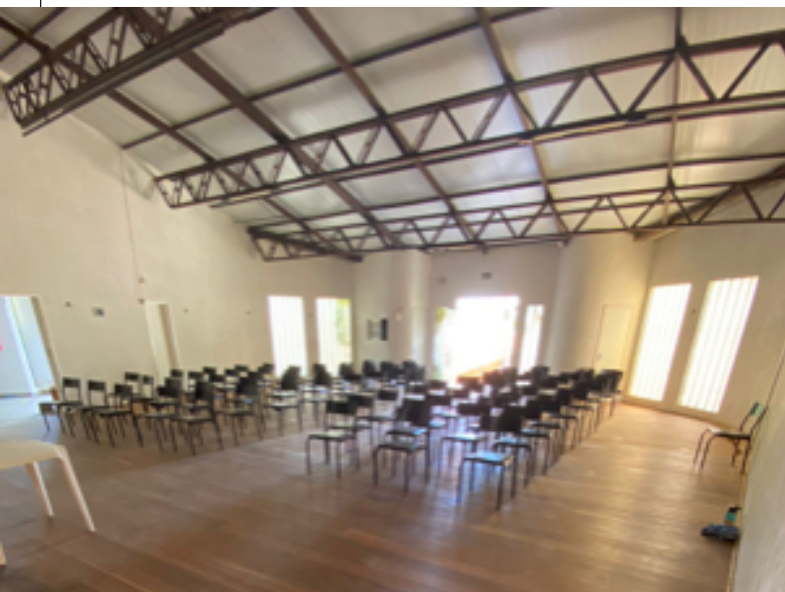
(esq) Novo piso de madeira do teatro. Setembro/24 / (dir) Nova coberta do teatro. Setembro/24
